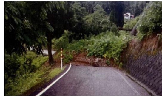
土砂崩れで寸断された道路 （住民撮影）
